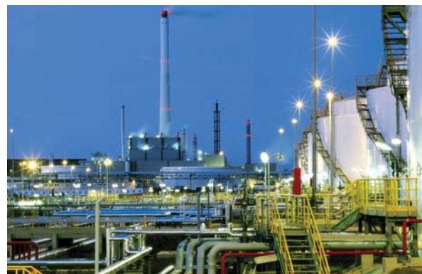
Парогазотурбинная электростанция в Лойна, Германия фотография © Siemens Press
